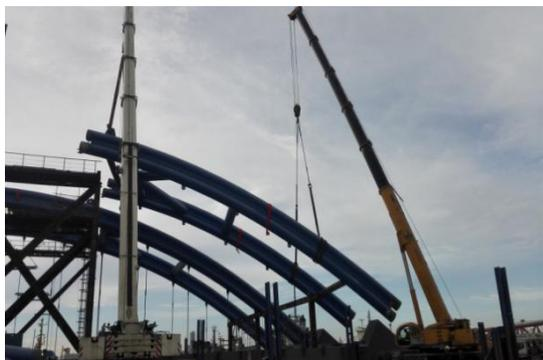
图10 拱肋的拼接（端段）
