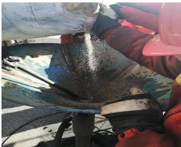
图 1 福 1X1 现场填砂施工作业
