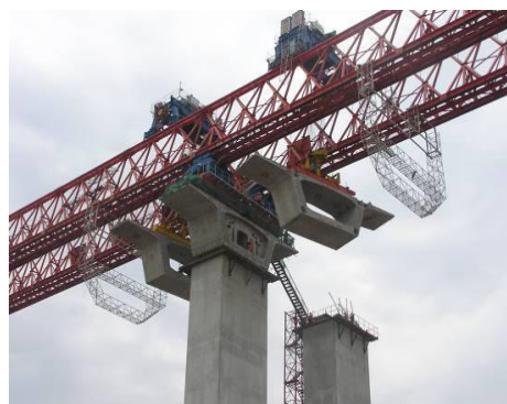
图 3 第一对箱梁起吊图
