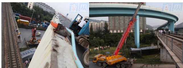
图1 重型货车坠桥砸断铁路
