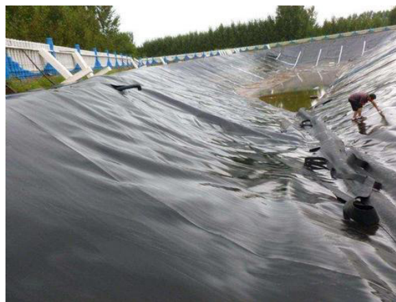
图2 渠道料膜铺设图
