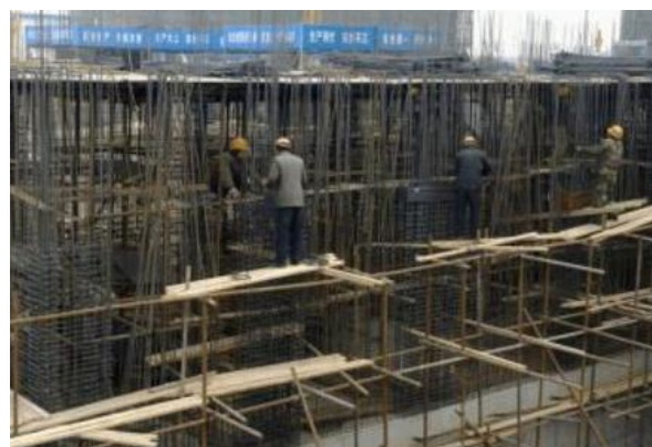
图2 高层施工现场
