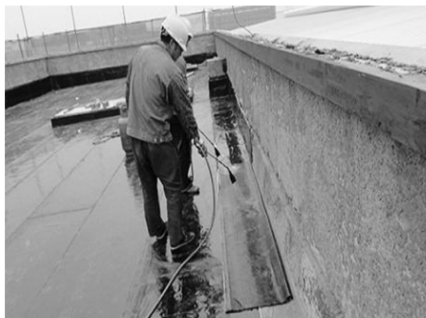
图1 防渗漏处理现场
