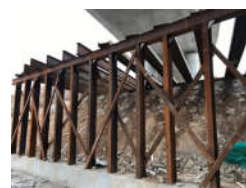
图 3 现场门洞支架施工
