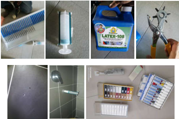
图2 瓷砖注浆修补工艺
