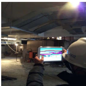
图 5 模型与实际安装对比
