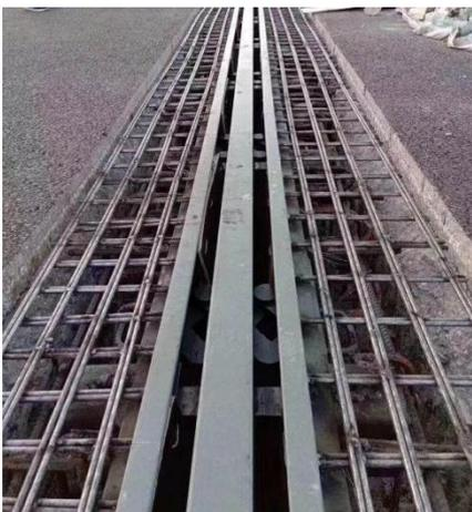
图1 公路桥梁伸缩缝示意图
