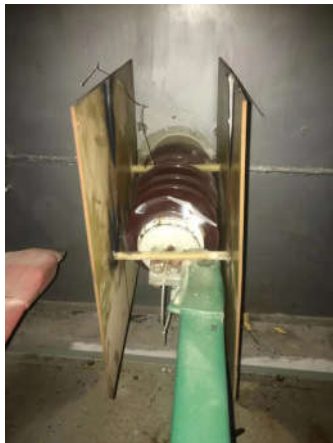
图 1 绝缘隔板击穿情况
