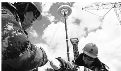
图 3 电气间隙放电试验施工
