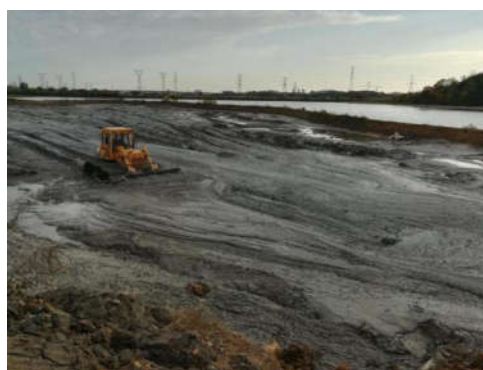
图1 污水污泥清理作业
