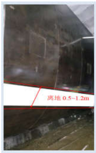
图 5 钢模台车及高分子透水布示意图
