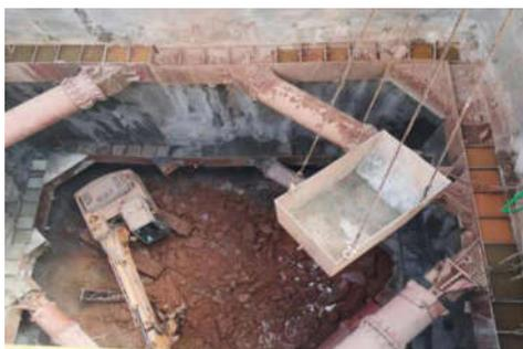
图4 基坑开挖平面示意
