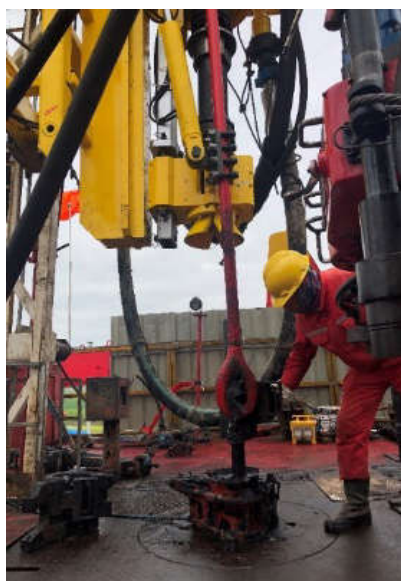
图3井口“一吊一卡”作业模式现场施工
