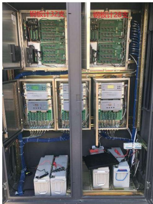
图4 围堰项目现场安装采集设备图
