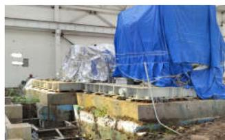
图1 设备撬座基础
