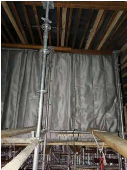
图4 梁侧热敷设膜铺设
