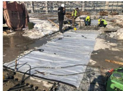
图 3 梁顶热敷设膜铺设
