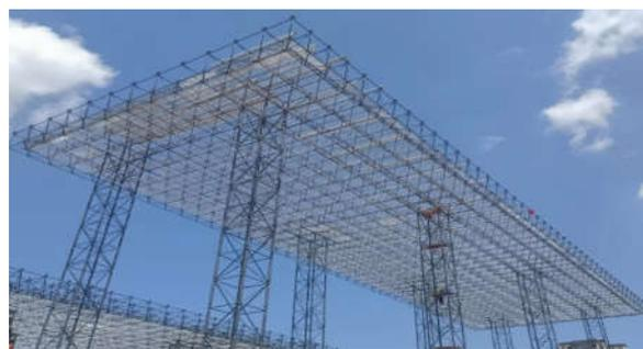
图2 整体顶升安装完成图
