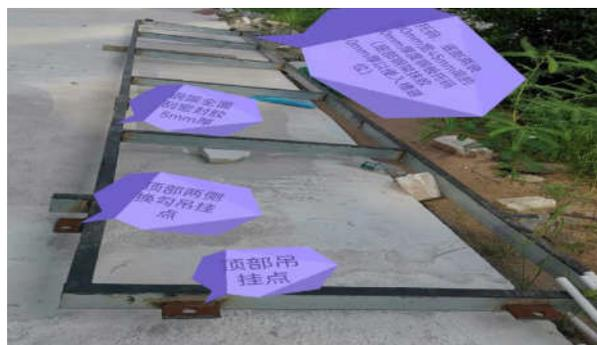
图 3 吊挂玻璃钢架制作示意图
