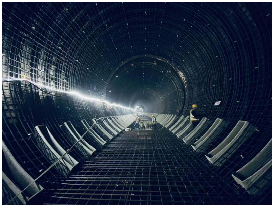
图 3-2 钢筋安装
