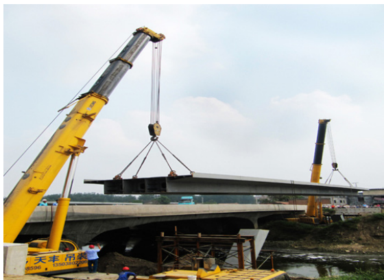
图 1 分段吊装工艺
