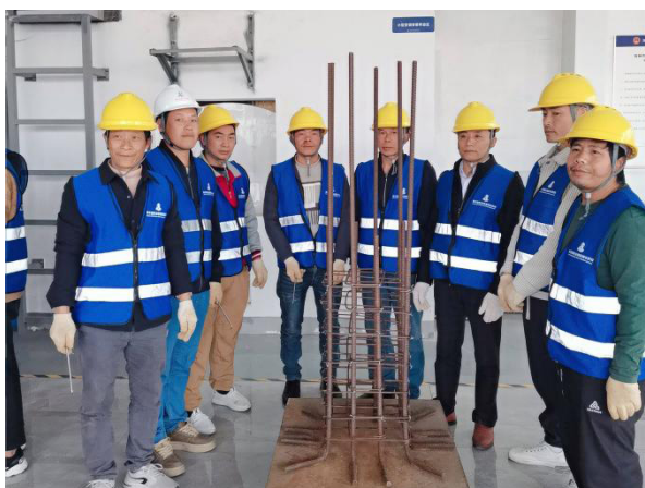
图2 施工人员培训现场
