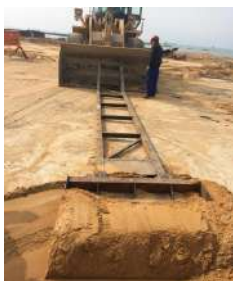
图4 装载机顶推钢斗掏沙
