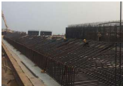
图3 沉箱底模铺设图
