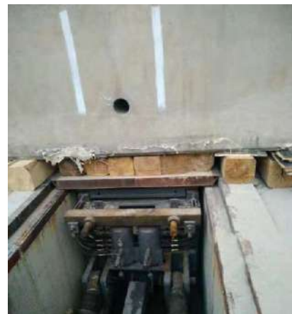
图 16 铺垫木排后沉箱顶升
