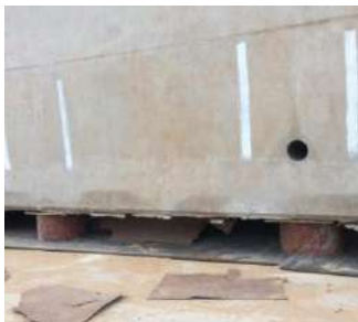
图 9 钢管支墩支撑
