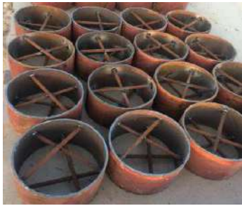
图 7 钢管支墩制作
