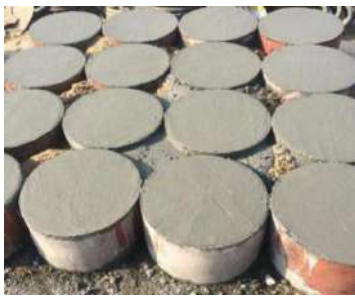
图 8 钢管支墩浇筑砼
