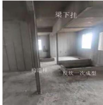
图 17 拆模后,成型质量
