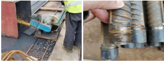
图3 现场钢筋加工
