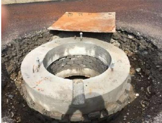
图 4 安装预制井圈
