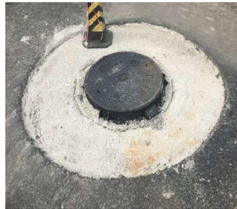
图 7 混凝土浇筑
