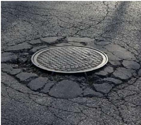
图 1 井盖周边沥青混凝土产生裂缝和破损
