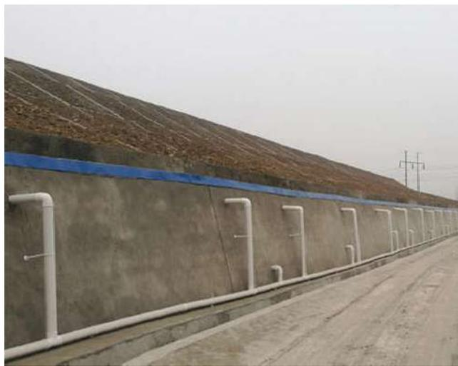
图2 磷石膏渣场整治项目渗滤液管道收集系统
