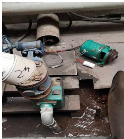
图 5 低位水泵检修
