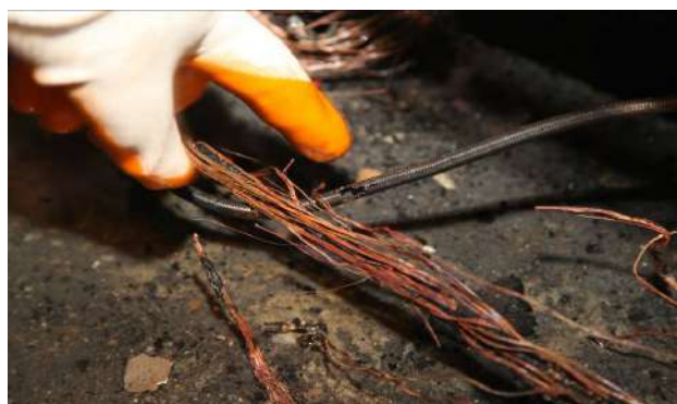
图9 2号电动自行车碟刹刹车管烧缺失
