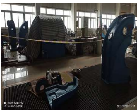
图 4 汽机解体检修
