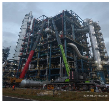
图5 1# 吊车配合将设备拉出, 2# 吊车系挂吊索具
