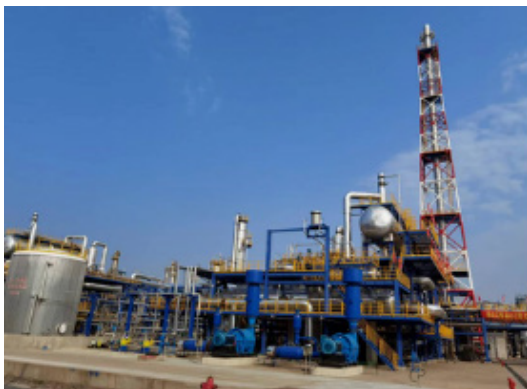
图1 石油化工建设
