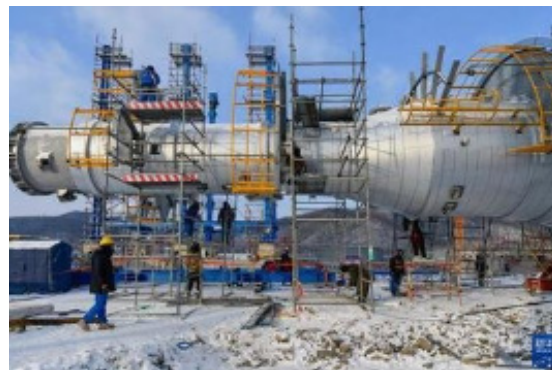
图2 石油化工建设项目安全检查
