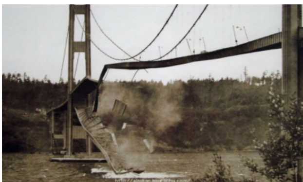
图1 美国塔科马海峡大桥
