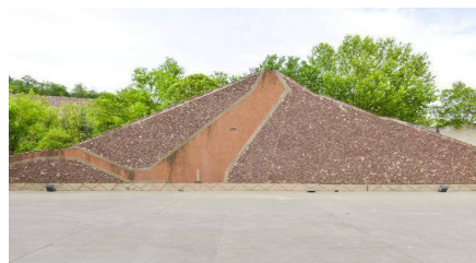
图1 混凝土防渗墙
