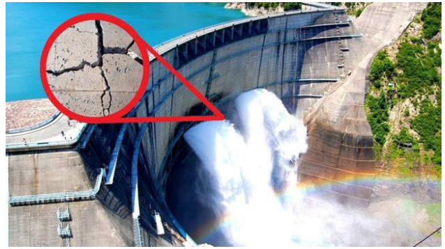
图2 水利工程大坝混凝土裂缝示意图
