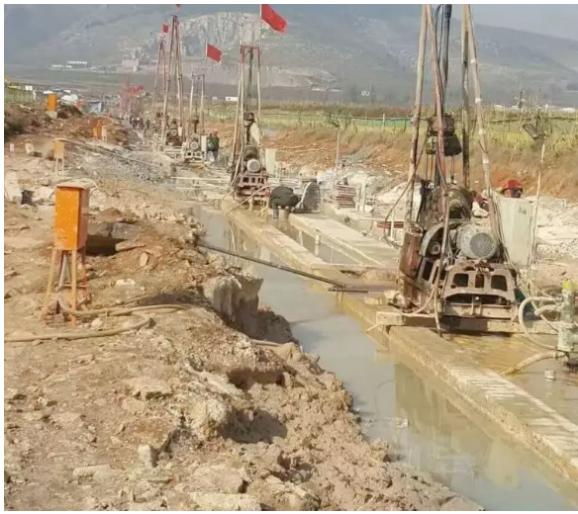
图1 某水库灌浆施工过程
