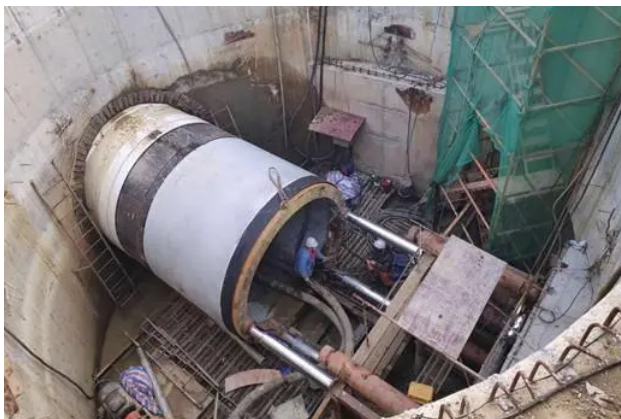
图2 顶管施工现场图
