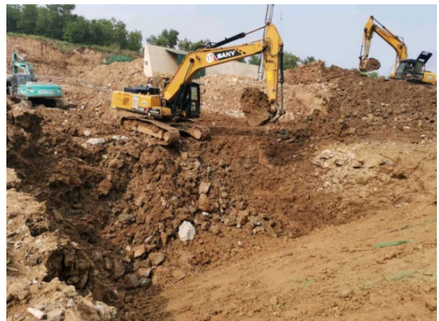
图1 土方开挖作业
