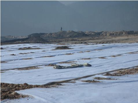
图 1 土工膜平面铺设图（一）
