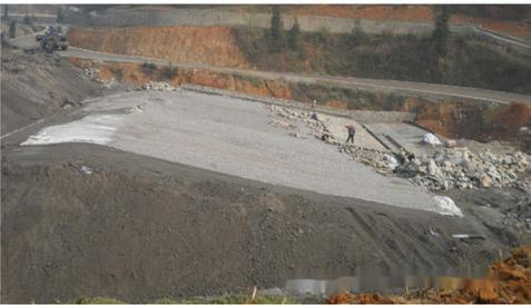
图 2 土工膜平面铺设图（二）
