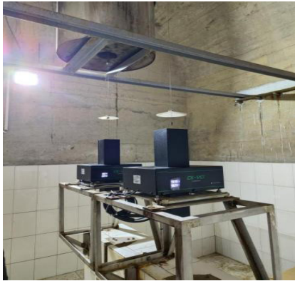
图3 垂线坐标仪安装图
