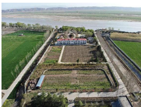
图1 温县引黄补源生态治理水源工程
