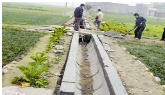
图1 水利设施检修
