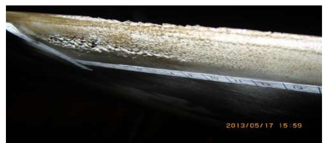
图3 2013年5月戈枕1号机组4#桨叶气蚀情况
