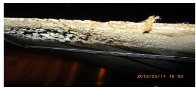
图4 2013年5月戈枕1号机组4#桨叶气蚀情况
