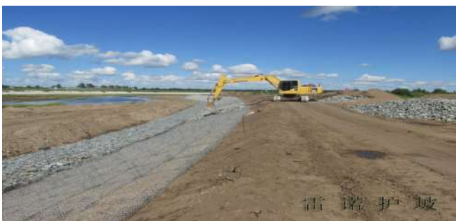
图2 石料填充施工图
