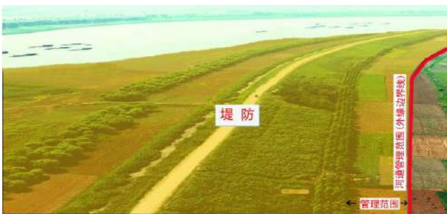
图2 有堤防河道管理范围边界线划分示意图 (堤防外坡脚加管理范围)
