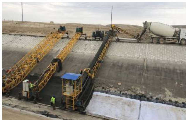
图2 技改项目施工现场
