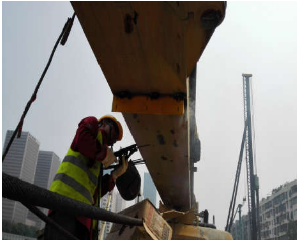
图7 托架安装
