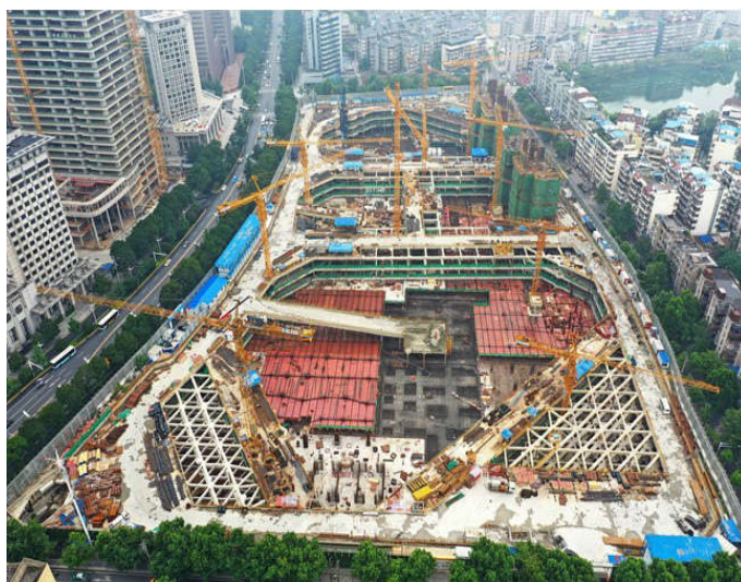
图 16 项目地下室全貌
