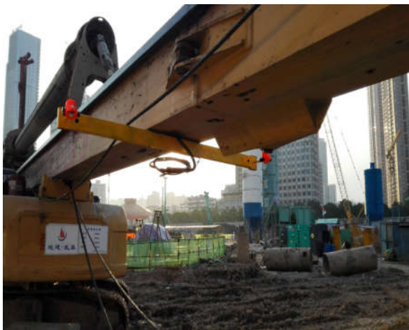
图8 定位架安装
