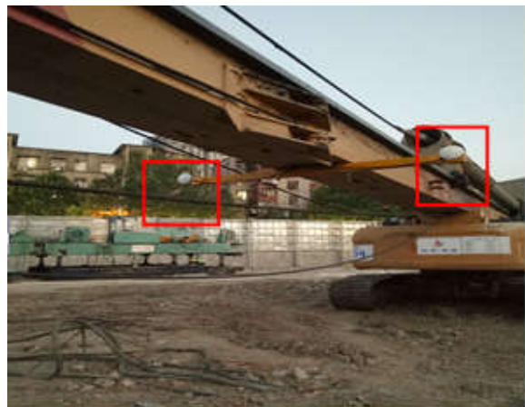
图11 定位架上安装天线
