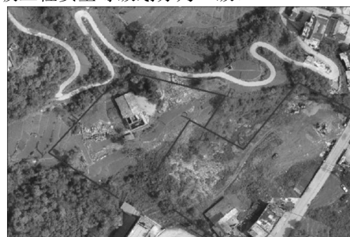
图 1 场地整平开挖后边坡位置图
