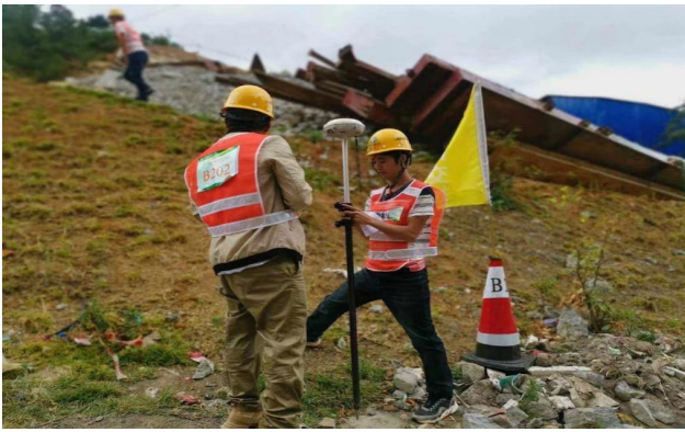
图 1 建筑工程 GPS 工程测量
