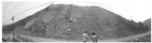
图1 崩塌地质灾害隐患点全景
