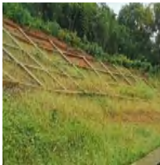
图1 滑坡地质灾害治理工程现场图
