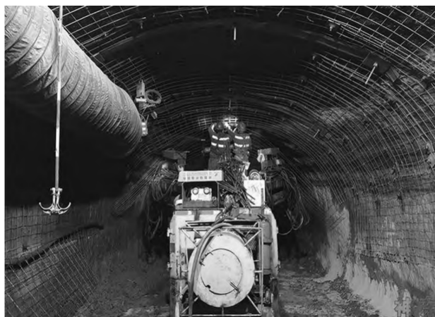
图1 巷道掘进现场
